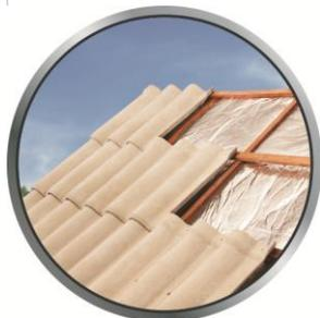
Para coberturas existentes onde não é necessária uma grande intervenção, há no mercado acessórios que viabilizam a vedação de frestas e reparos de peças com pequenas trincas. A vedação ou reparos podem ser feitos de duas formas, através de selante elástico ou de manta autoadesiva aluminizada.
