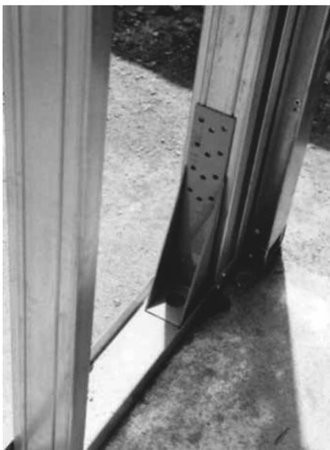
Foto 2.13 - Peça de reforço na ancoragem da estrutura à fundação por meio de barra rosca
