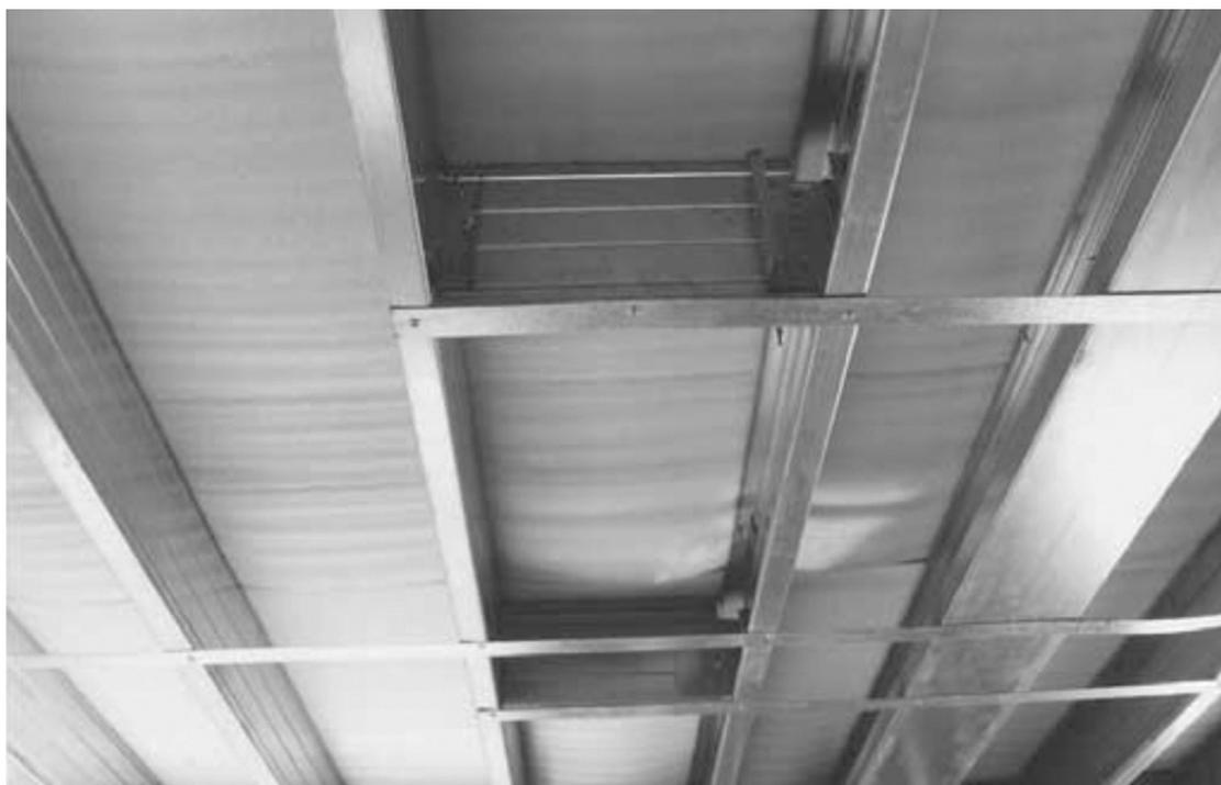
Foto 4.8 - Travamento horizontal da laje de piso por meio de bloquedores e fitas metálicas
