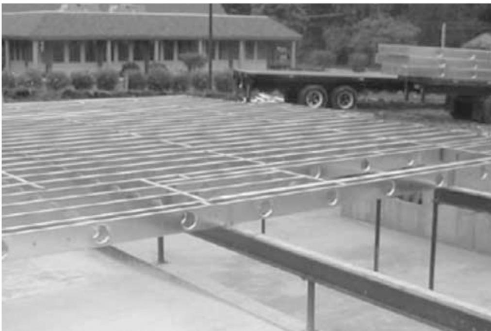
Foto 4.7 - Vigas de piso apoiadas sobre viga principal em aço (Fonte: <http://www.aegismetalframing.com>)
