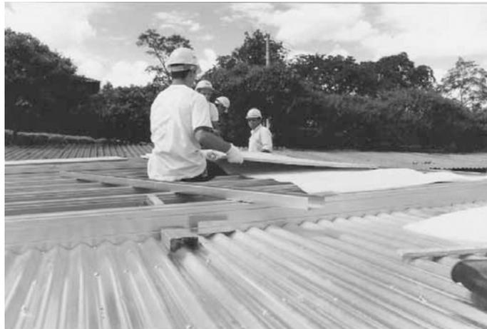
Foto 4.3 - Forma de aço para contrapiso úmido
