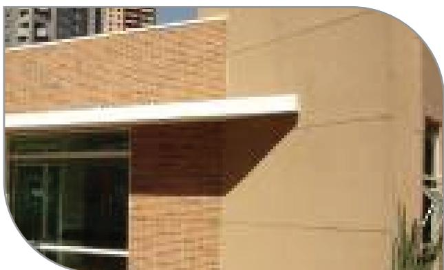
Juntas aparentes em fachadas permitem o uso de mata-juntas ou canaletas metálicas.
