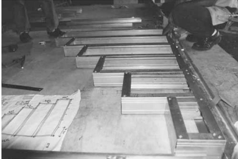
Foto 4.10 - Montagem de uma escada de painéis escalonados
