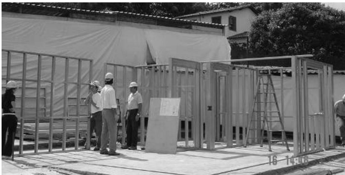
Foto 2.10 - Elementos estruturais como tesouras e painéis são pré-fabricados em oficinas e levados à obra para montagem da estrutura (Fonte: <http://www.aegismetalframing.com>).
