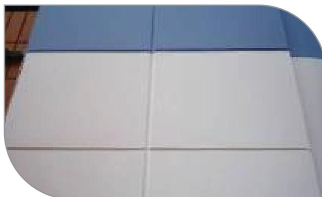
Juntas abertas em fachadas, necessário o uso de **Selamax** entre as juntas para garantir estanqueidade.
