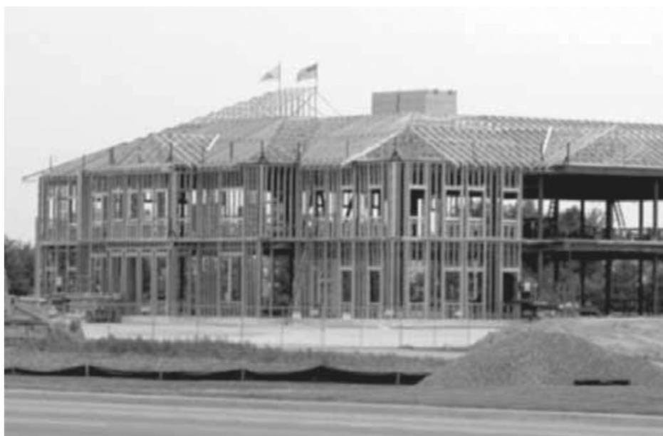
Foto 5.5 - Telhado com interseção de vários planos (Fonte: <http://www.aegismetallframing.com>)
