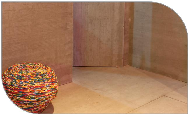
Juntas aparentes para fechamentos internos, sem necessidade de selante entre as juntas.
