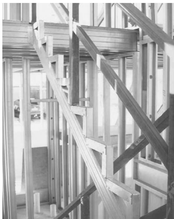
Foto 4.9 - Escada viga-caixa inclinada
