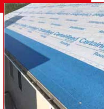
Impermeável e aderente, serve para facilitar a montagem, corrigindo pequenas imperfeições da superfície e proporcionando uma base perfeita de ancoragem para as telhas.
