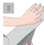
3 Retire a película de plástico e puxe o filme descartável lentamente enquanto o BrasiTape é esticado, colado e apertado, para eliminar bolhas de ar e rugas. Podem ser usados roletes de borracha ou madeira para apertar e fixar melhor o produto na superfície.
