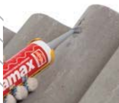
Reparos em telhas de fibrocimento
