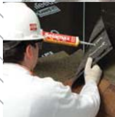
Fixação e vedação em outros tipos de telhas, como a telha Shingle Brasilit
