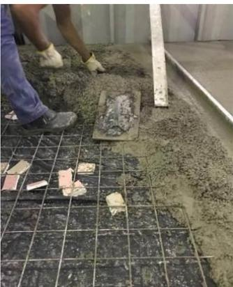
Figura 6: Lançamento do microconcreto do contrapiso.
