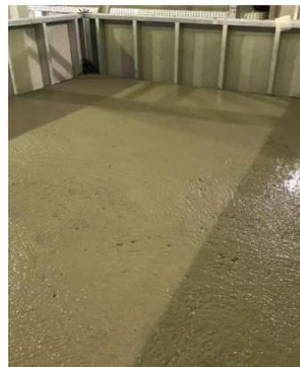
Figura 7: Camada de contrapiso finalizada e acabada.
