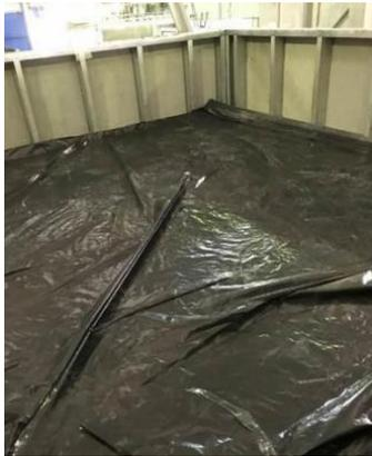
Figura 4: Colocação do filme de polietileno sobre os painéis.
