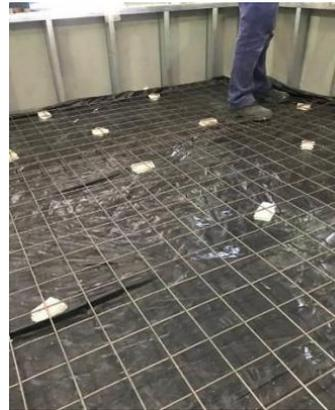
Figura 5: Colocação da tela de aço e espaçadores.
