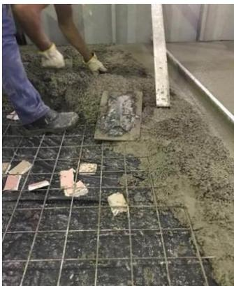
Figura 6: Lançamento do microconcreto do contrapiso.
