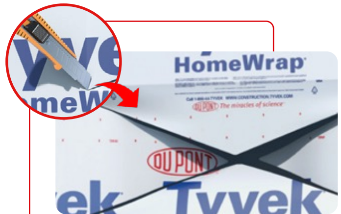
Figura 3: Instalação da membrana hidrófuga em aberturas.
