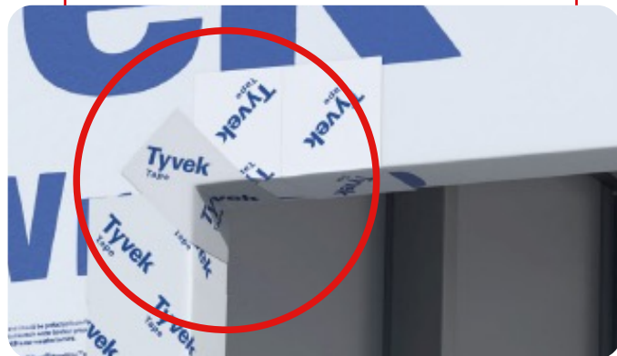
Figura 4: Proteção dos perfis em quinas e vãos com Tyvek® Tape.
