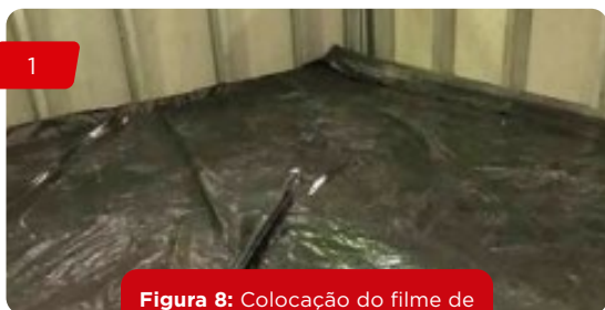
Figura 8: Colocação do filme de polietileno sobre as placas.
