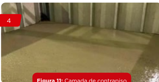
Figura 11: Camada de contrapiso finalizada e acabada.
