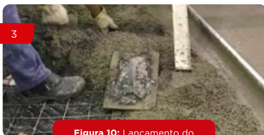
Figura 10: Lançamento do microconcreto do contrapiso.
