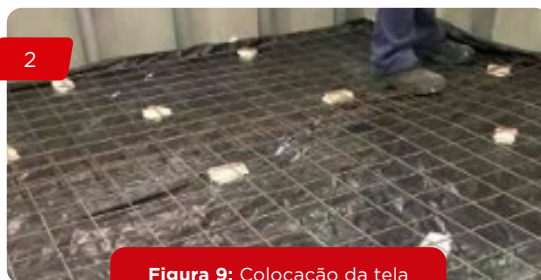
Figura 9: Colocação da tela de aço e espaçadores.
