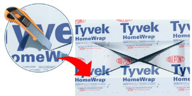
Figura 4: Instalação da membrana hidrófuga em aberturas.
