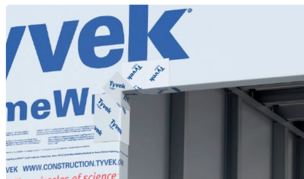
Figura 5: Proteção dos perfis em quinas e vãos com Tyvek® Tape.
